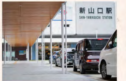
シェルター（屋根）の設置で雨に濡れにくくなりました。柱には、種田山頭火の句と中原中也の詩が記されています
