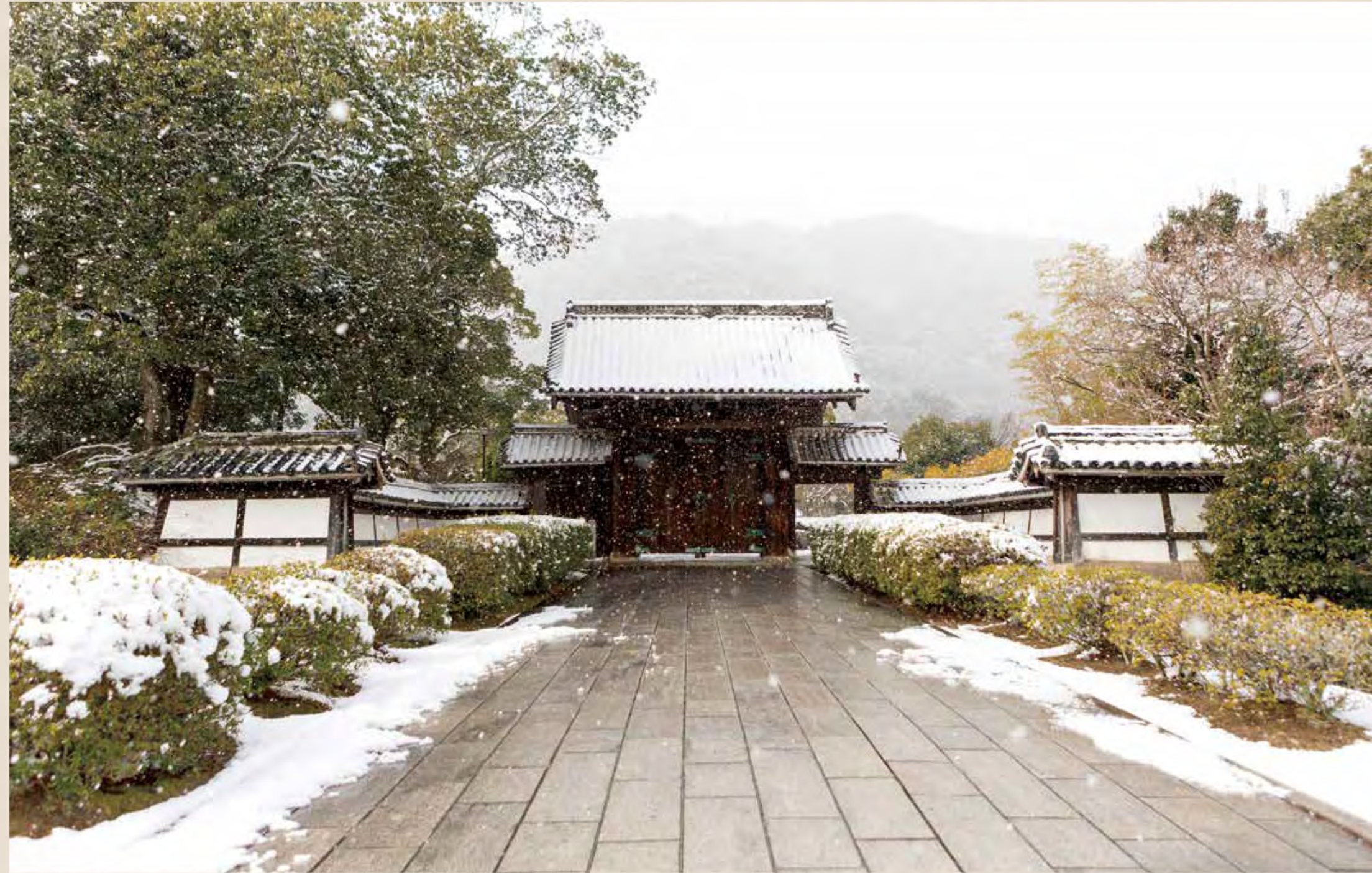
旧山口藩庁門 藩庁門前、山口県庁の敷地を取り囲むようにある堀は幕末に山口御屋形が造られた際に造営されたものがほぼそのままの形で残っている。堀端は桜とツツジの名所として知られる。毛利の家紋を示す藩庁門の「丸瓦」(写真左下)
