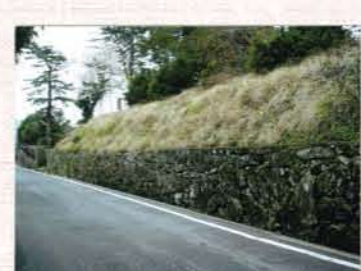
山口城東砲台前面の石垣と土塁の遺構 豊沙門山(香山)の東南麓から洞春寺の山門脇まで香山通りに面して築かれた砲台の遺構
